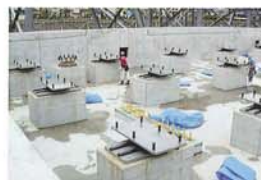
基礎の内部にはリニアスライダーなどの免震装置を設置した
