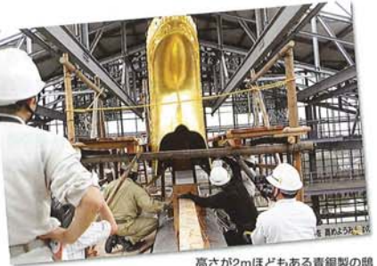
高さが2mほどもある青銅製の鸚尾（しび）を設置した
