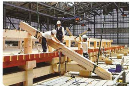
尾垂木を設置する様子。木の特性を生かして施工精度を確保した
