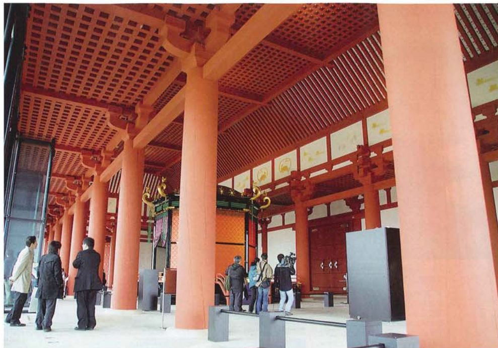
柱の高さは約5m、天井高は約10mだ。ヒノキの柱を始めとして約2400㎡の国産材を使った。柱の半数が奈良県産だ。内部には、高御座（たかみくら）と呼ばれる天皇の玉座（写真中央）などを展示した。施工者は竹中工務店・浅沼組・森本組JVだ（写真：44ページとも本誌）
