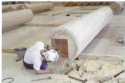
柱の仕口を加工する様子。樹齢約250年の国産のヒノキなどを用いた
